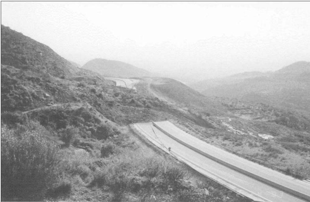
Σχήμα 2. Ανώτερο τμήμα αστοχίας και καταστροφή της Ν.Ε.Ο. μεταξύ των Χ.Θ. 16+300 έως 16+600
