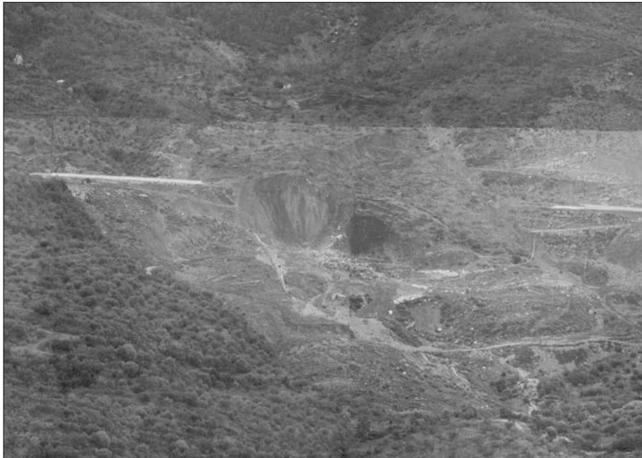
Σχήμα 1. Συνολική άποψη της κατολίσθησης
