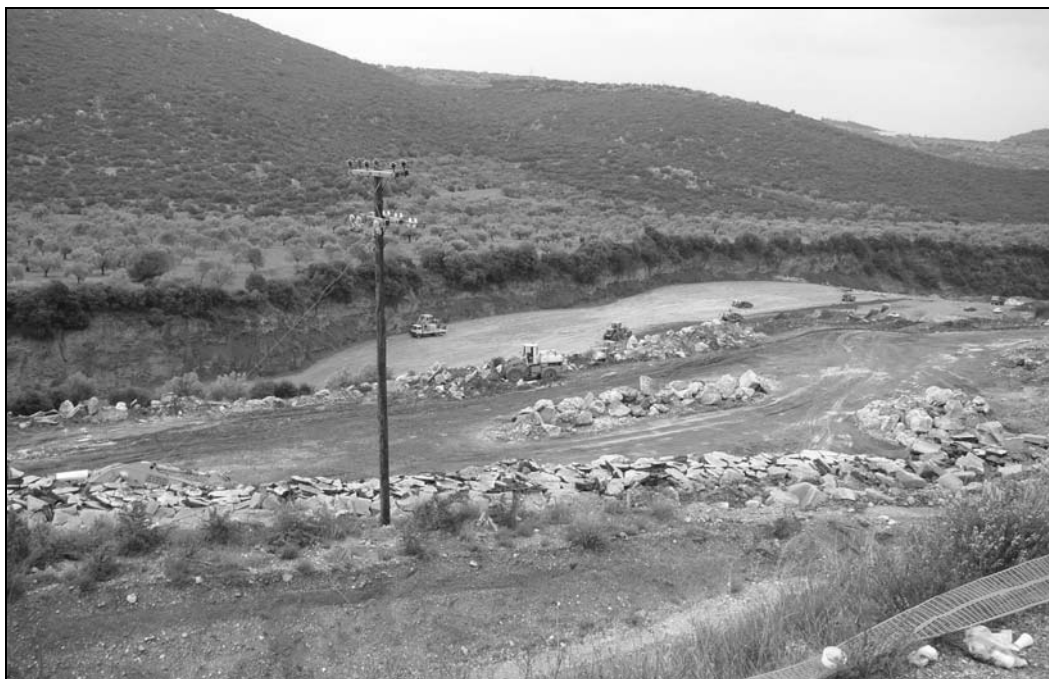
Σχήμα 7 Άποψη της περιοχής ενδιαφέροντος κατά την κατασκευή του σταθεροποιητικού επιχώματος.
