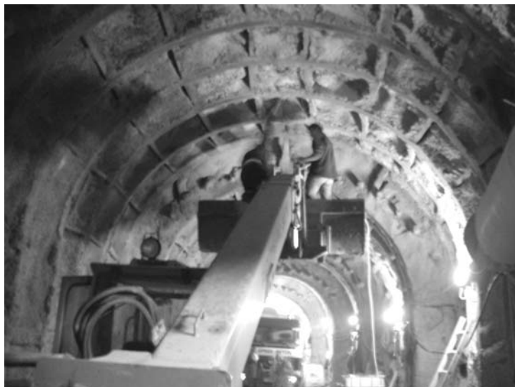
Σχήμα 4. Εφαρμοσθείσα τυπική διατομή της σήραγγας. Κάτω: «Οδόντωση» από διαδοχική εφαρμογή δοκών προτορείας.
